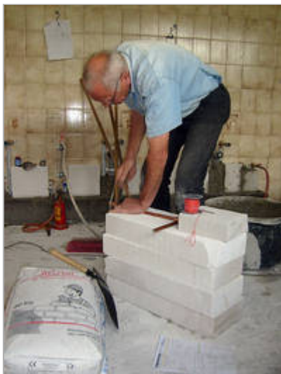
Auch Hubert Mühling, Ex-Schatzmeister der Bruderschaft, ist es zu verdanken, dass die Damentoiletten erneuert werden.
