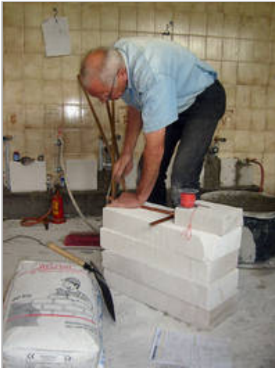
Auch Hubert Mühling, Ex-Schatzmeister der Bruderschaft, ist es zu verdanken, dass die Damentoiletten erneuert werden.
